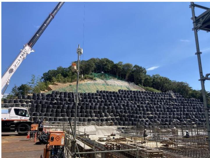
新東工場建設工事の横の法面崩壊状況
